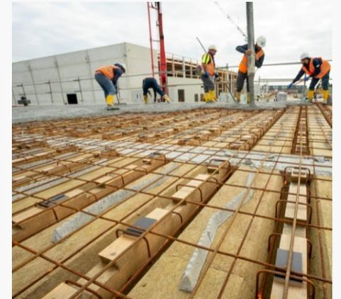
➤ **Usine de préfabrication des FOB en remplissage en béton de chanvre**
